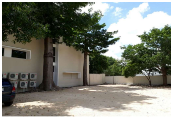
F3: Fachada posterior
