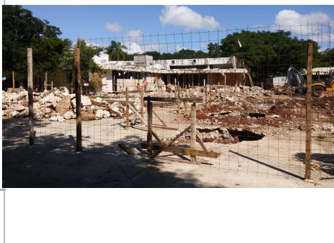
F3: Fachada lateral
